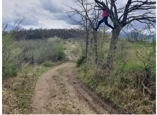
Zusätzlich wurde die Straße mit einer Schicht Sand bzw. feinem Kies bedeckt. Darauf soll eine weitere Schicht grobkörniger Kies kommen, wodurch eine bessere Zufahrt gewährleistet wird.
